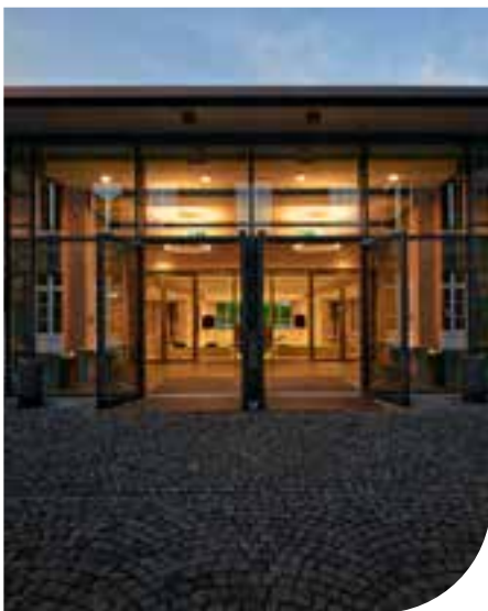
Die begehbare Dachterrasse des neuen Forums
